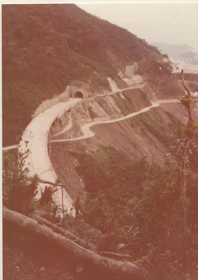
FOTO 2 - Visão panorâmica de tre cho cho do VA-10 e do em bo que SP do TA-7. Obser var var escorregamento o cor rido sobre o trecho do TA-7 construído a céu aberto. (Trecho VI da Ro do ovia dos Imigrantes).
