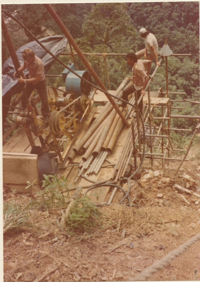
FOTO 5 - Sondagem sendo executada no maciço do TA-7 . (Rodovia dos Imigrantes, Trecho VI).
