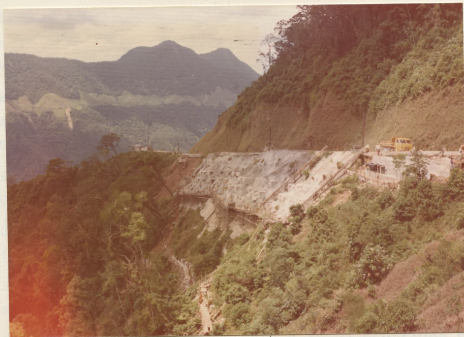
FOTO 6 - Em primeiro plano, obras de contenção numa estrada de serviços, na Rodovia dos Imigrantes. Ao fundo, trecho da FEPASA, na encosta à margem direita do Rio Cubatão.
